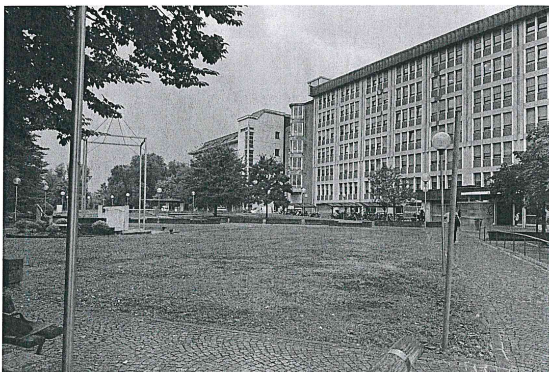
Vista dell'area e sullo sfondo la facciata dell'Ospedale.
